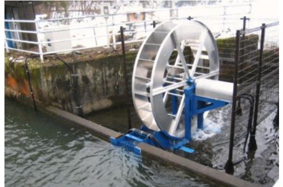
設置した実証試験用水車
